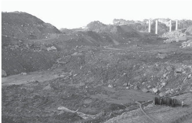
Obras da Circunvalación na parroquia no Campo
